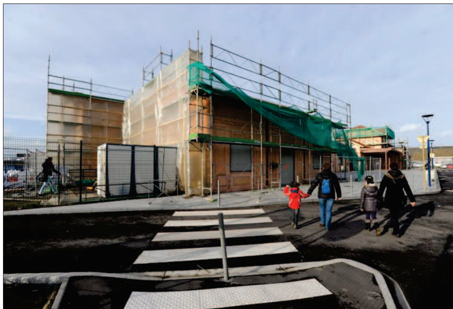
■ Le site des travaux de désamiantage est complètement isolé ce qui évite toute propagation d'amiante.
