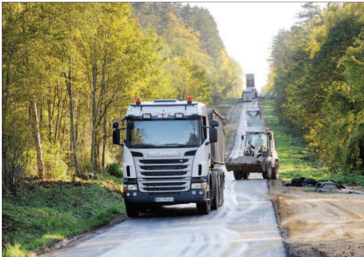
■ Deux mois de travaux, mais des années de négociations auront été nécessaires pour voir les camions en action sur la route d'Ornes.
