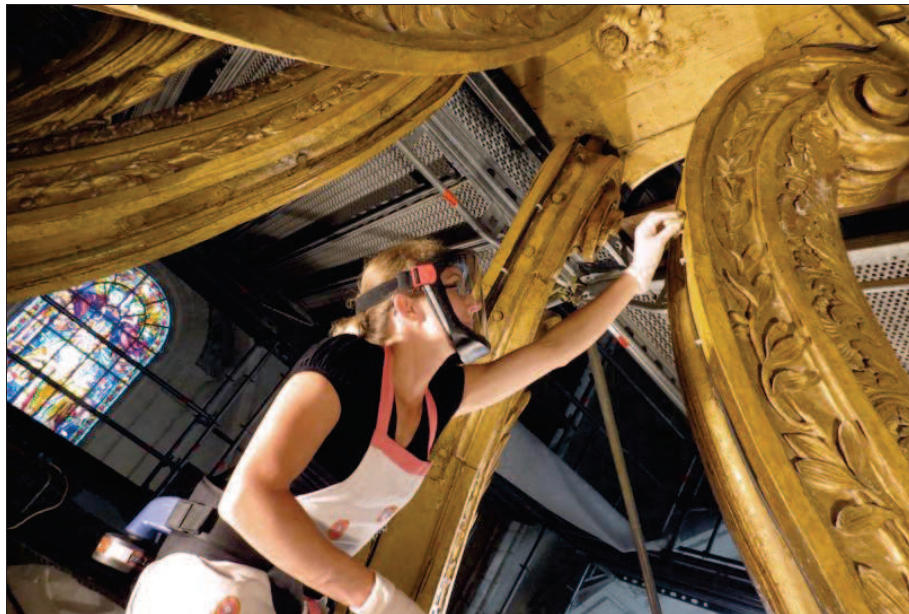
■ Claire Dard-Ternisien à l'œuvre sur la structure surplombant le ciel du baldaquin.
